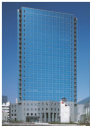
A-26 シーバンスS棟
