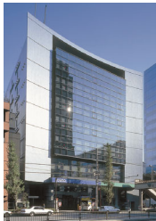
A-25 JREコスモ金杉橋ビル
