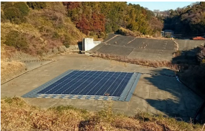
湘南桂台第二雨水調整池
